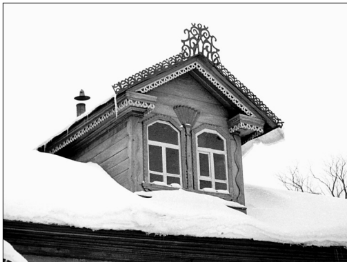
Просечной гребень светелки жилого дома в Гороховце (бывшее с. Красное). Начало XX в.
